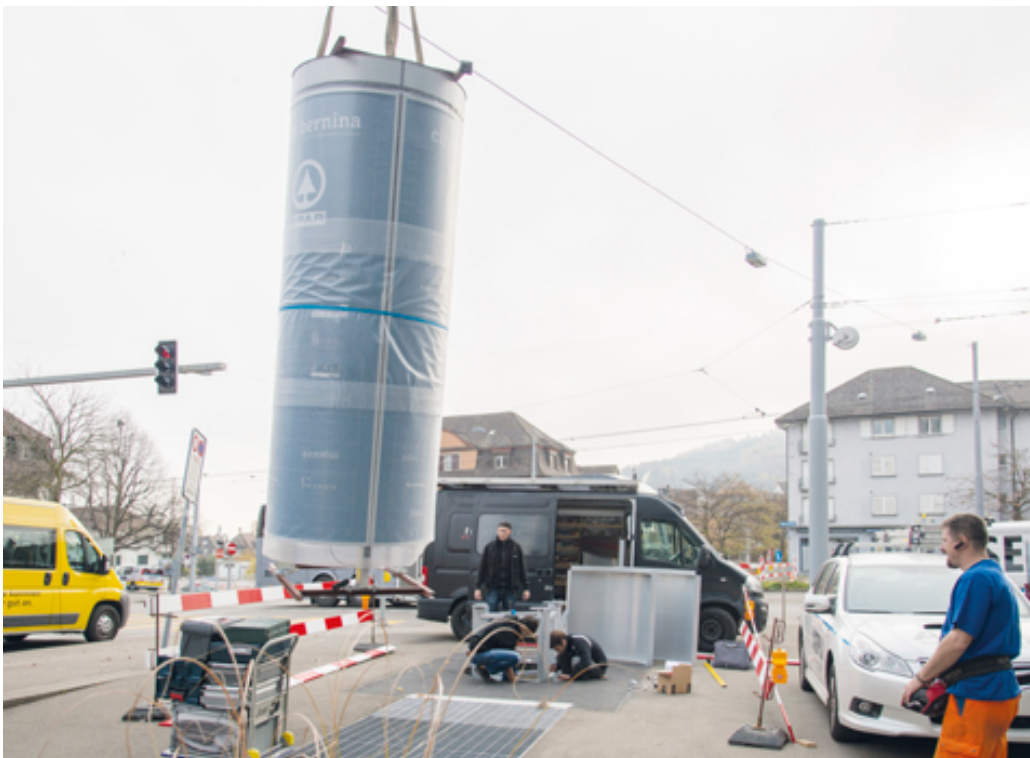
Positionierung mit Kranen
